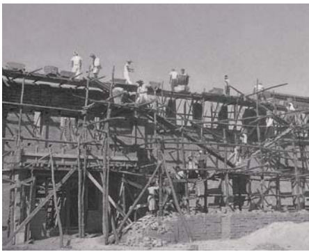
교사 증축 공사 (1954)
