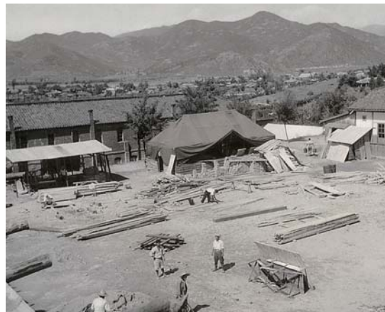
교사 증축 공사 (1955)
