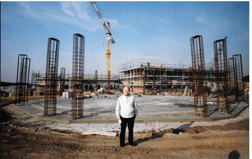
한인신학원 신축 공사장 _ 로마(1999. 10. 14)
